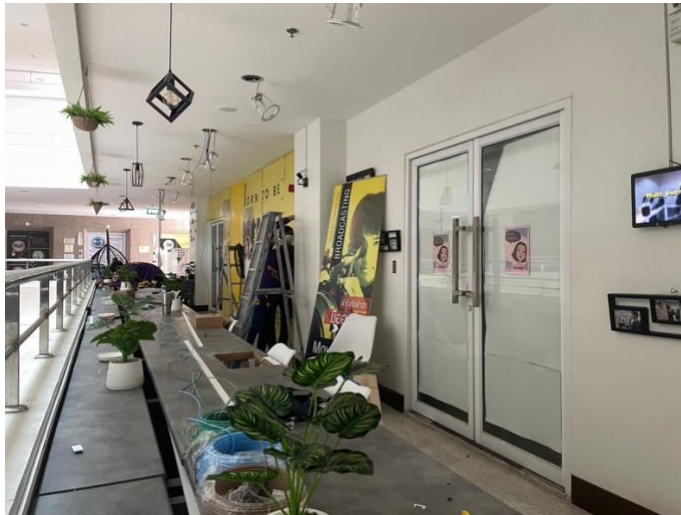
ภาพที่ ค-9 การติดตั้งวัสดุ และอุปกรณ์ในพื้นที่ Reading Zone
