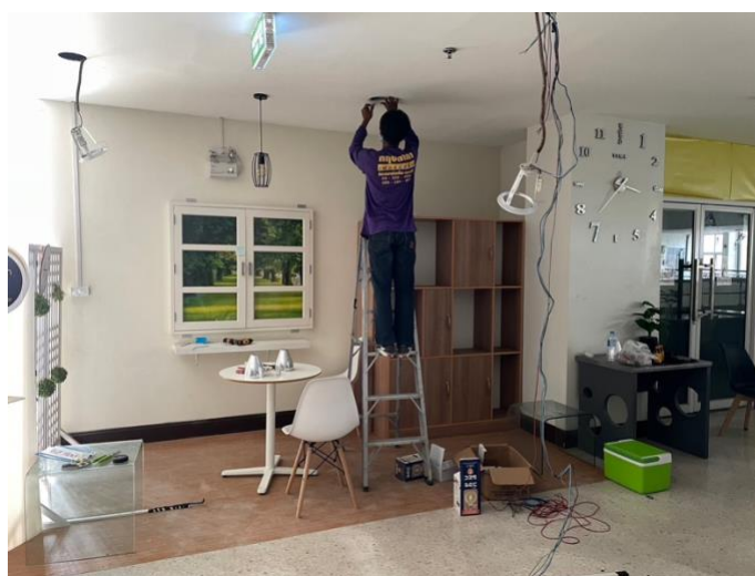
ภาพที่ ค-8 การติดตั้งวัสดุ และอุปกรณ์ในพื้นที่ Check in Zone
