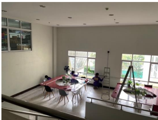
ภาพที่ ค-11 การติดตั้งวัสดุ และอุปกรณ์ในพื้นที่ Co - learning Space Zone
