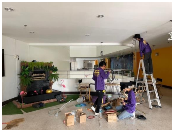
ภาพที่ ค-7 การติดตั้งวัสดุ และอุปกรณ์ในพื้นที่ Closed to Nature Zone
